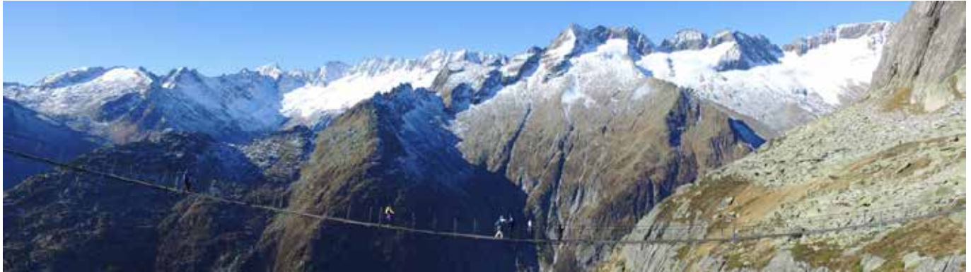
Salbit-Brücke, Quelle: www.salbit.ch
