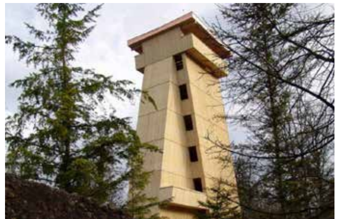
Der 29 m hohe Caminada-Turm
