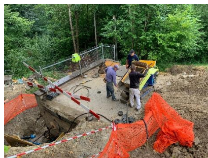
Abbildung 4: Baustelle QWPW Chilegg
