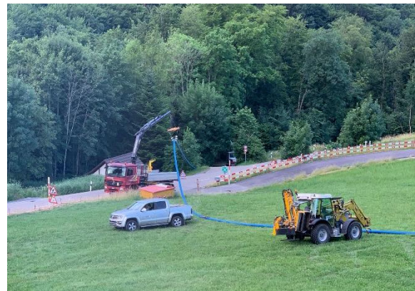
Abbildung 1: Einzug der Wasserleitung in das Bohrloch
