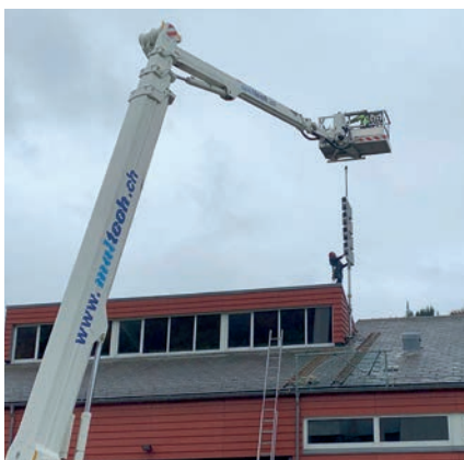
Die neue, elektronische Sirene (Bild) ist nun auf dem Dach des Werkhofes installiert.
