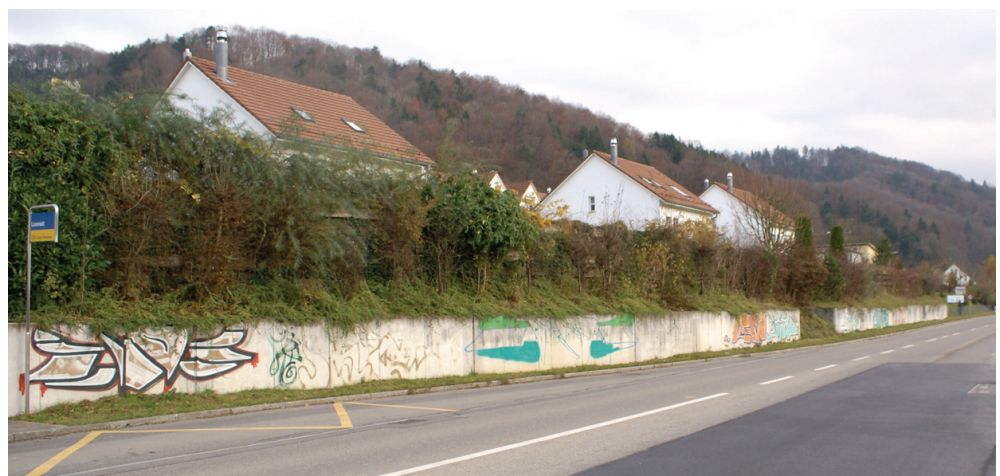
Abb. 9: Bestehender Lärmschutz entlang der Reppischtalstrasse, Ortsteil Sellenbüren ("Loomatt")
