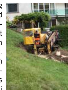
Die Bohrmaschine im Rebhölzli im Einsatz
